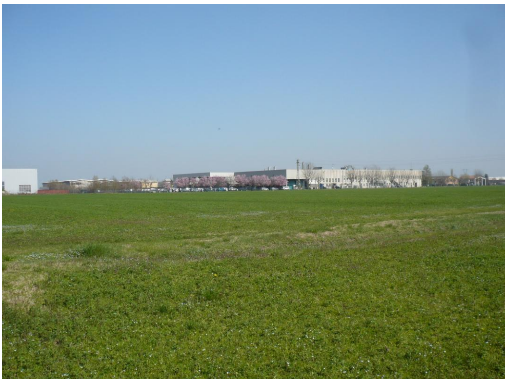
FOTO 32: lato sud-est visuale dell'area e del fabbricato esistente
