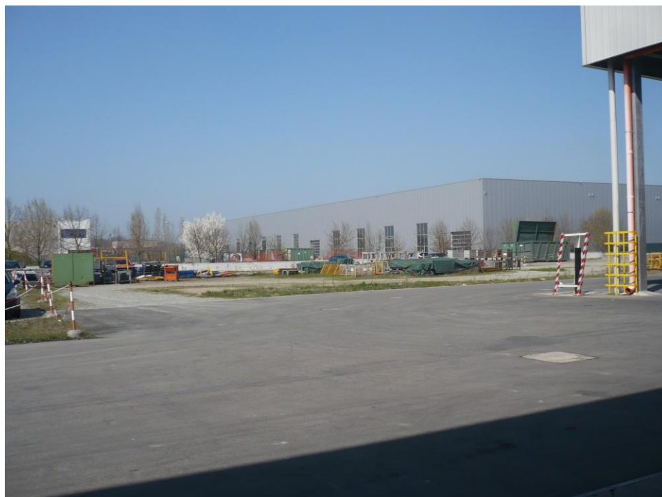
FOTO 12: lato ovest zona deposito a cielo aperto
