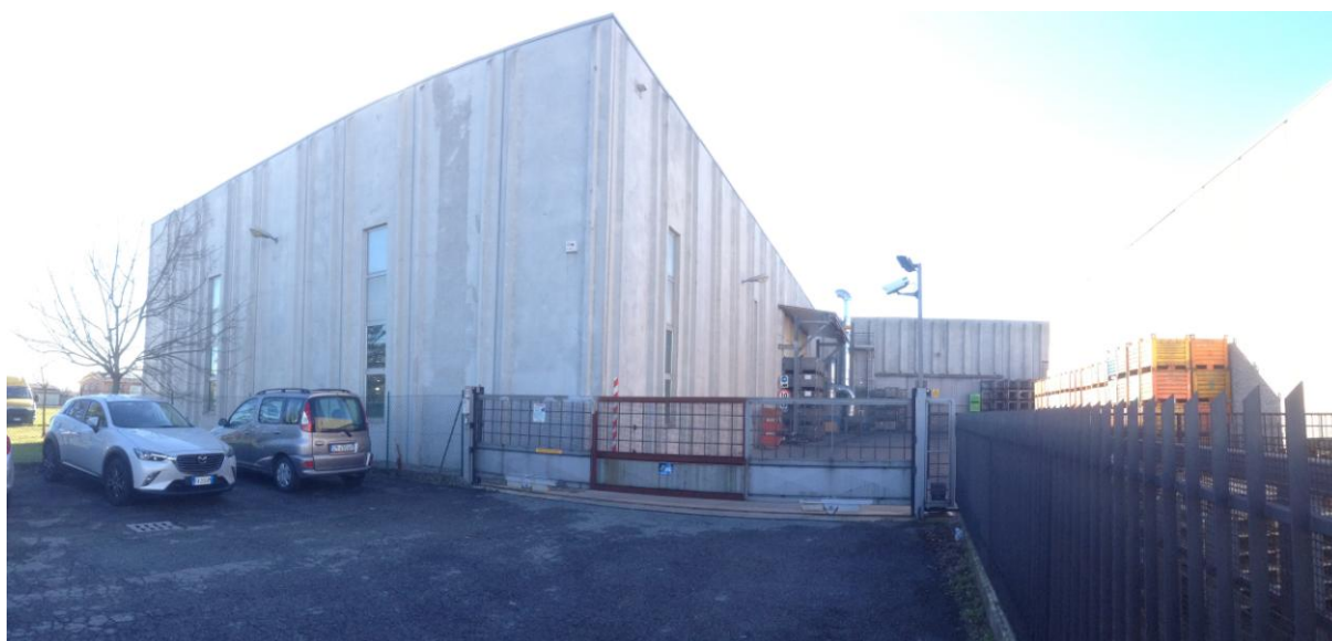
FOTO 25: lato nord ingresso dei mezzi pesanti
