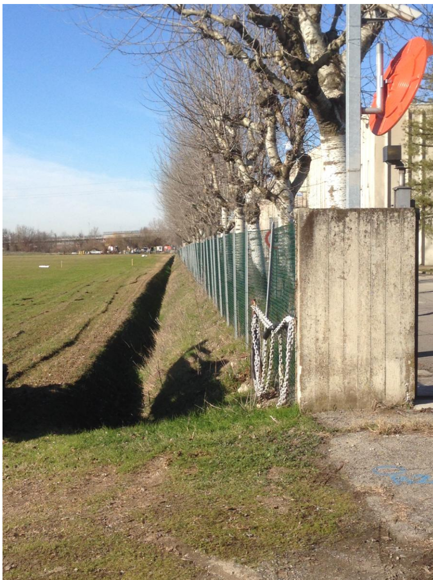
FOTO 7: lato sud confine tra edificio esistente ed area di ampliamento
