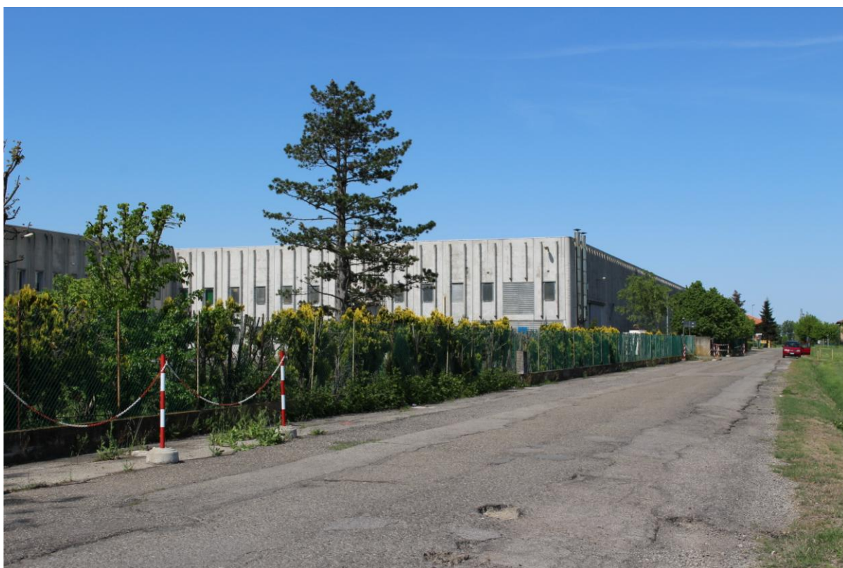
FOTO 4: lato est strada privata che permette l'accesso al fabbricato
