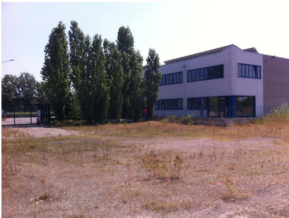
FOTO 22: lato ovest edifici confinanti
