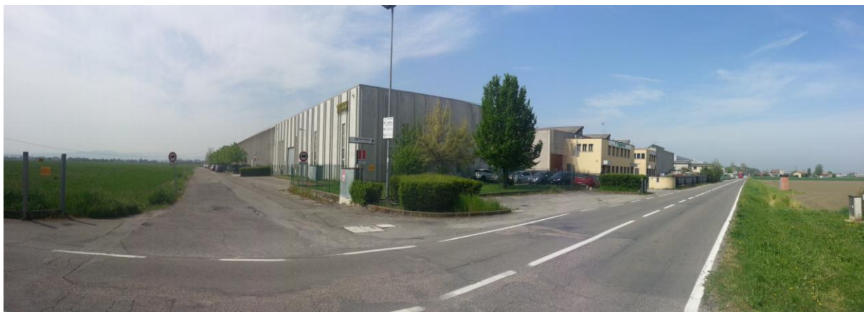
FOTO 1: lato nord-est ingresso della fabbrica esistente
