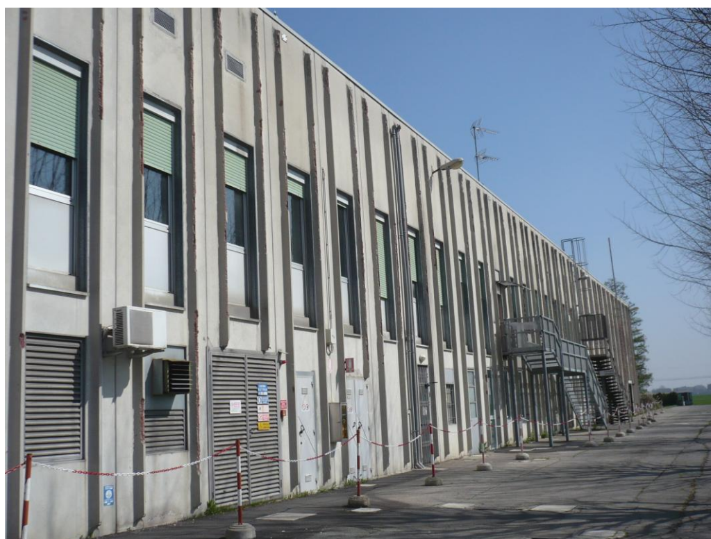
FOTO 9: lato sud facciata dell'edificio esistente
